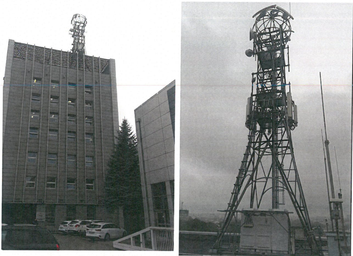
Widok obiektu wraz z zainstalowanym zespołem antenowym
